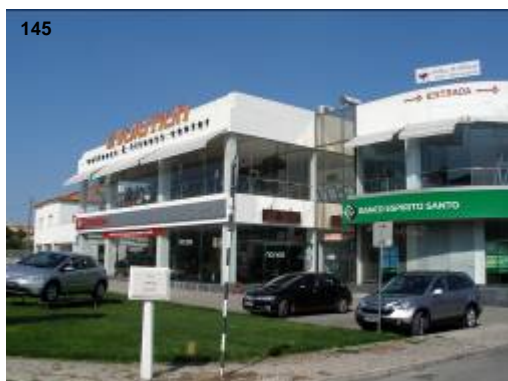
Fig. 145 - Edifício do EC1, Montijo – (fonte: fotografia do autor)
