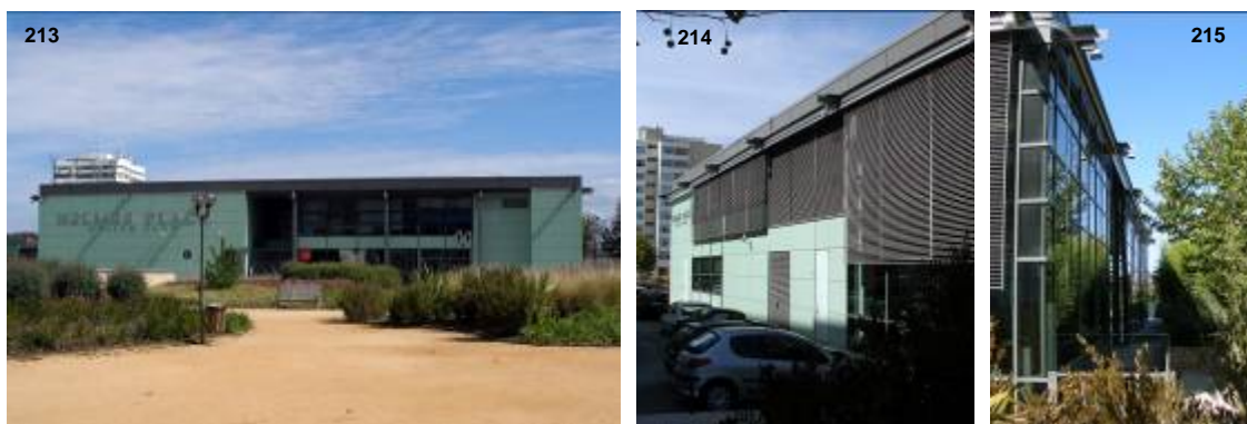
Fig. 213 – Edifício do EC3, Miraflores – (fonte: fotografia do autor)
