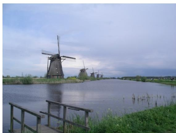
**Fig.2.51** – Kinderdijk perto de Roterdão na Holanda – sistema de drenagem composto por 19 moinhos de vento, construído por volta de 1740. Desde o séc. XIII que a Holanda usa este sistema para ganhar terra ao mar.
