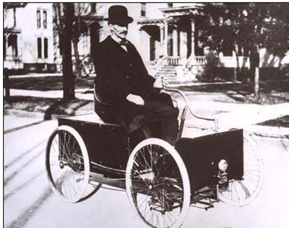
**Fig.2.58** – Quadriciclo – veículo a motor de Henry Ford em 1896 (em 1885 Karl Benz e Gottlieb Daimler inventam o motor de combustão interna que permite criar o automóvel)
