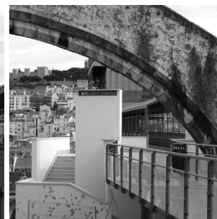
FIGURA 179. Passadiço ruínas do Carmo
