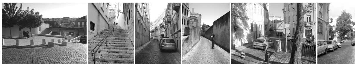
FIGURA 209. Ligação Martim Moniz/R. Marquês Ponte de Lima 1 R. da Vitória 2,3 Edifícios propostos para aproveitamento 4 R. dos Fanqueiros 5 R. da Madalena FONTE da autora, 2008
