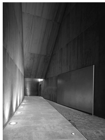
FIGURA 53. Acesso a elevadores
