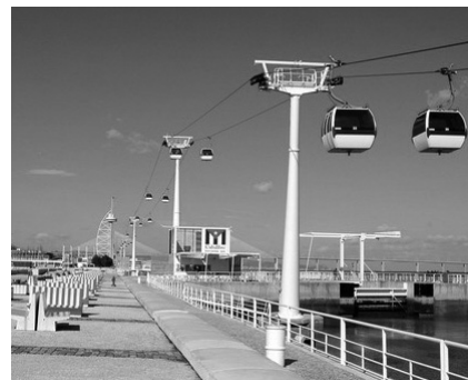
FIGURA 73. Teleférico do Parque das Nações, Lisboa (Portugal) FONTE www.guiadacidade.pt , nd
