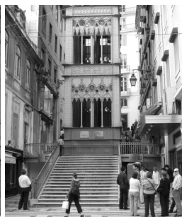
FIGURA 176. Entrada para o Elevador
