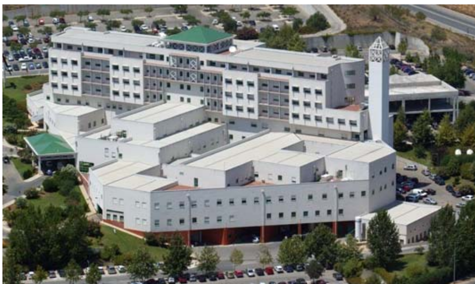
Figura 3.1 – Hospital de Portimão fotografia aérea
