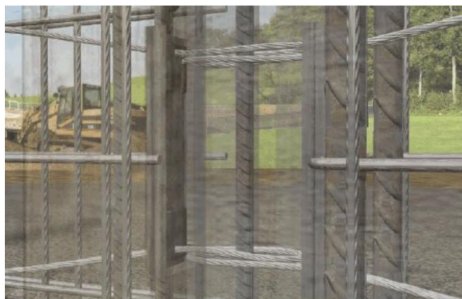
Figura 2.35 – Aplicação do Philipp Power Box em paredes resistentes [33]
