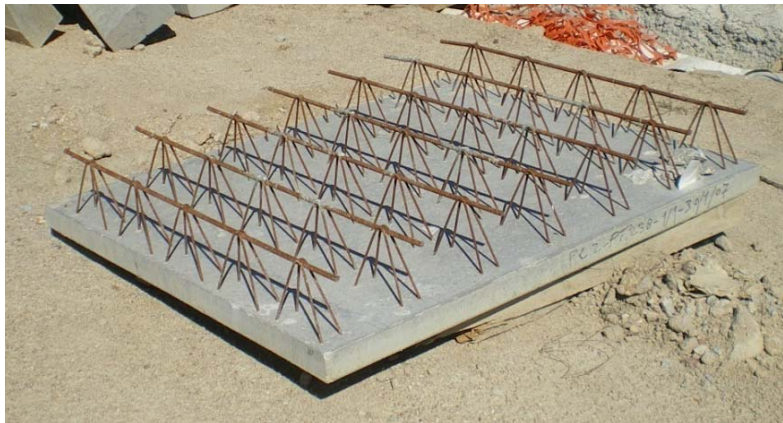
Figura 2.2 – Pré-laje maciça com estribos salientes 1
