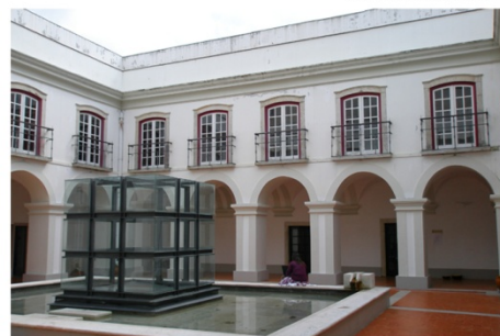
(3) Claustro do antigo Convento
