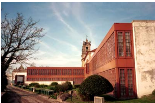
Figura 11 Novo corpo de quartos da Pousada (fonte: DGEMN)
