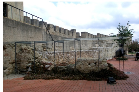
(4) Muralha do Castelo a envolver a zona exterior da Pousada
