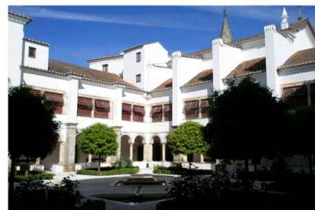
(3) Claustro do antigo Convento
