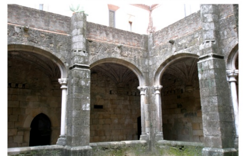
(3) Claustro do antigo Convento
