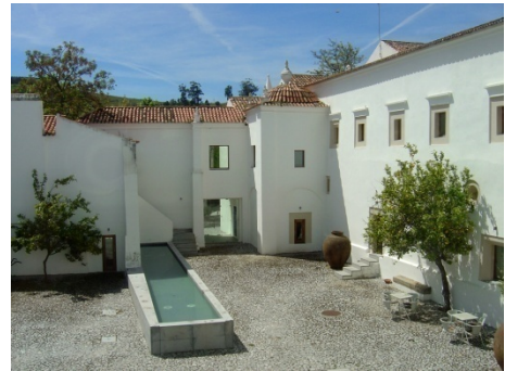
Figura 20 Novo pátio conjugando o existente e a nova construção.
