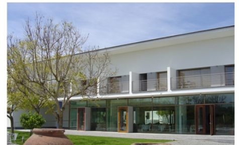
(2) Nova Ala dos Quartos vista da zona da recepção
