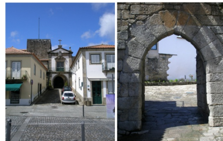
(2) Acesso ao interior da muralha onde se desenvolve a Pousada
