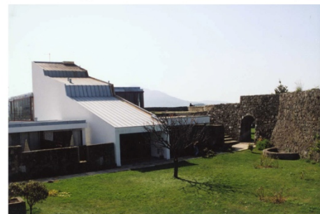
(4) Novo corpo da Pousada - Restaurante (fonte: DGE MN)
