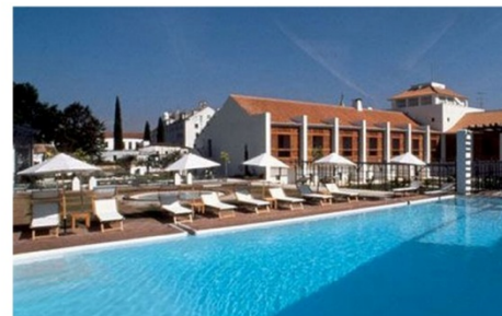
(2) Nova Ala dos Quartos vista da zona da recepção
