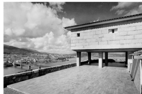
(4) Zona em terraço sob o piso dos quartos (fonte: DGE MN)
