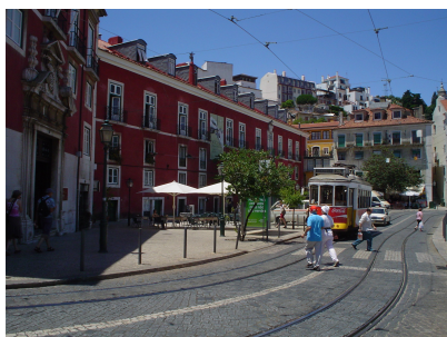
Figura 115: Vista para o Palácio dos Condes de Azurara
