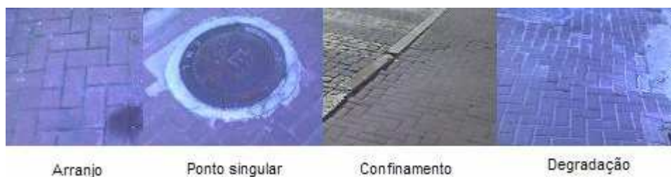
Figura 7. 6 Pontos de Interesse calçada de Betão
