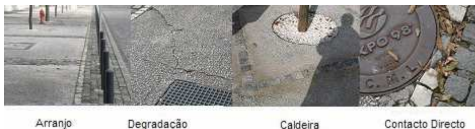
Figura 7. 10 Pontos de Interesse Laje de Betão e Calçada Natural Passeio
