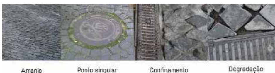
Figura 7. 8 Pontos de interesse Calçada de Pedra Natural
