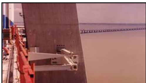
Figura 6.1: Dissipadores hysteréticos utilizados na Ponte Vasco da Gama [40].
