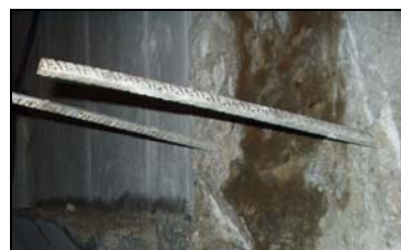
Figura 5.6: Varão nervurado selado com epoxi.
