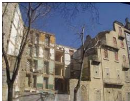
Figura 1.1: Edifício demolido próximo da Praça do Marquês do Pombal [3].
