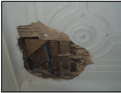
Figura 2.13: Tecto, visível os ripados e barrotes que constituem o pavimento [3].
