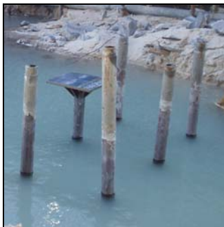
Figura 5.1: Utilização de micro-estacas no reforço de fundações
