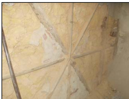
Figura 2.2: Parede de frontais com “Cruzes de S to . André”.
