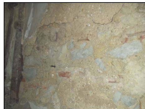
Figura 2.11: Alvenaria de pedra das paredes resistentes [3].
