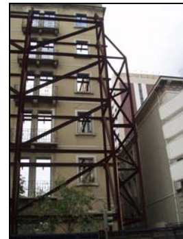
Figura 5.2: Escoramento da fachada
