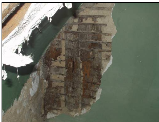
Figura 2.12: Parede interior em tabique [3].
