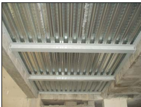
Figura 5.8: Laje colaborante assente em perfis metálicos.
