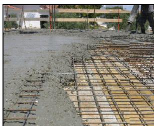
Figura 5.5: Betonagem de uma laje de betão [S14].
