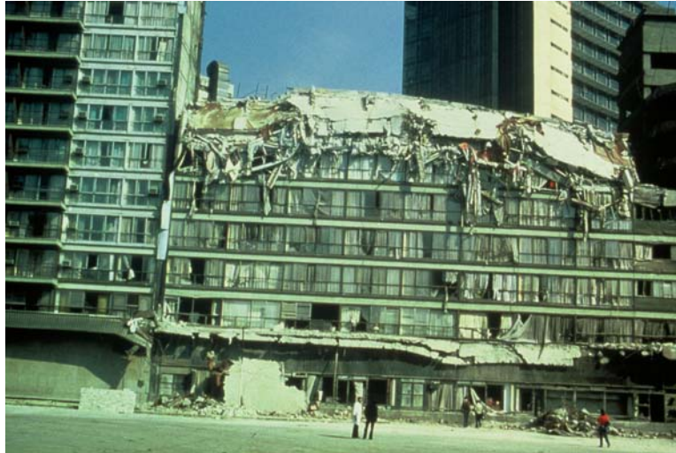
Figura 2.5 – Danos em edifícios adjacentes [EERI México II, 1987].
