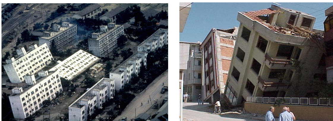
a) b) Figura 2.11 – Efeito da liquefacção de solos: a) Niigata, 1964 e b) Turquia, 1999.
