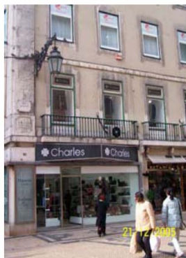
Figura 2.23 – a) Edifício com pilares cortados no rés-do-chão posteriormente à construção original ; b) Exemplo de descontinuidade de pilares no rés-do-chão ; c) Exemplo de pisos vazados.
