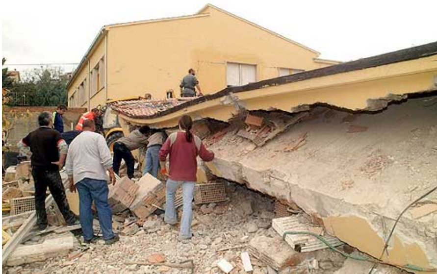
Figura 2.1 – Escola primária de San Giuliano, colapso do edifício. Sismo de Molise ( San Giuliano di Puglia , Itália, 31 de Outubro de 2002).
