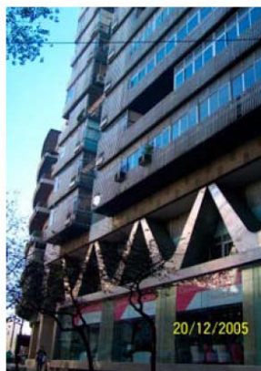
Figura 2.23 – a) Edifício com pilares cortados no rés-do-chão posteriormente à construção original ; b) Exemplo de descontinuidade de pilares no rés-do-chão ; c) Exemplo de pisos vazados.
