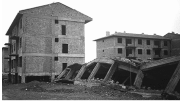
Figura 2.34 – Pilar-fraco viga-forte.
