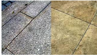
Fig. 2 – Ladrilhos Modulares aplicados num pavimento exterior
