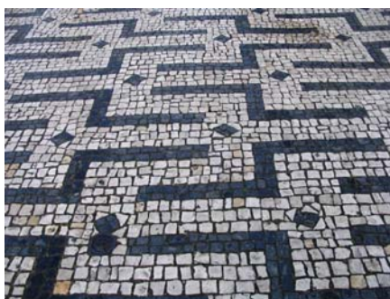
Fig. 1 – Calçada Portuguesa aplicada num pavimento exterior
