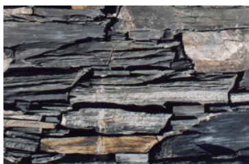
Fig. 5 – Ardósia aplicada na construção de paredes ou muros
