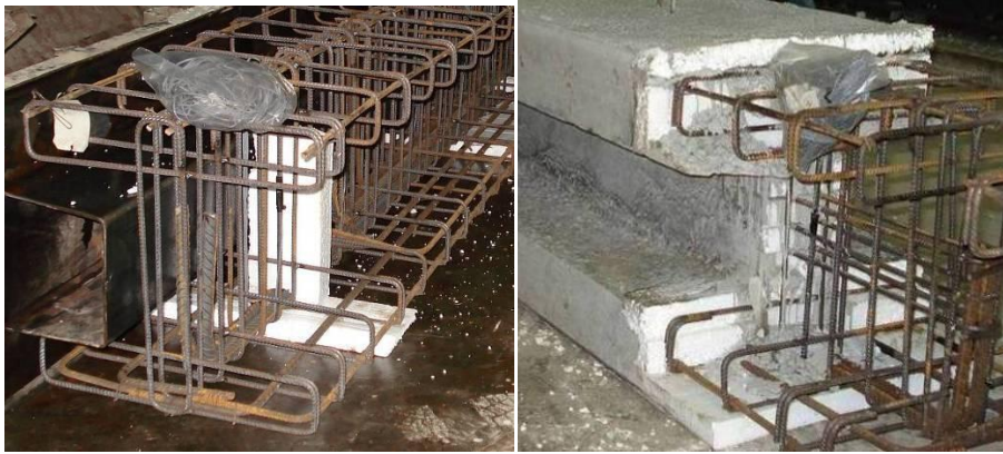
Execução das vigas com construção por fases
