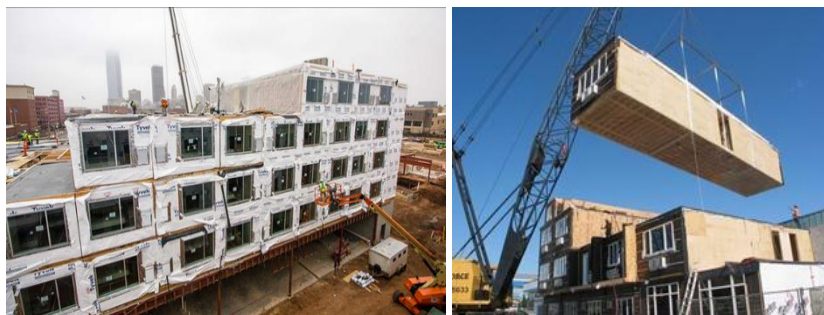
Figura 4 - Fotografias da montagem de módulos tridimensionais.
