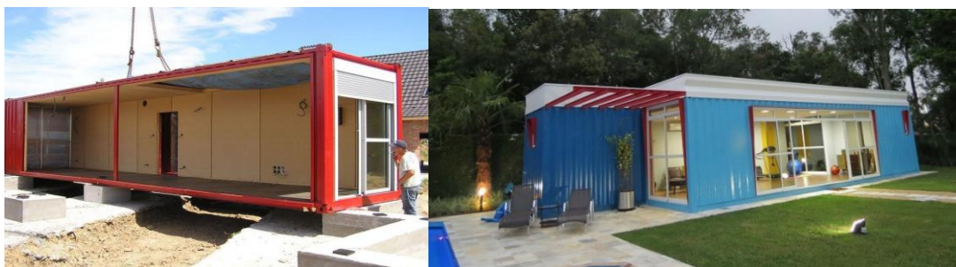
Figura 6 - Exemplo de módulos parcialmente abertos (fonte Inhabitat, 2021).
