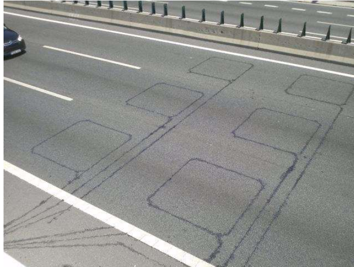
Figura 2.1 - Sensores de laço indutivo [17]
