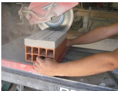
Figura 3.25 - Realização de entalhes com a máquina de corte
