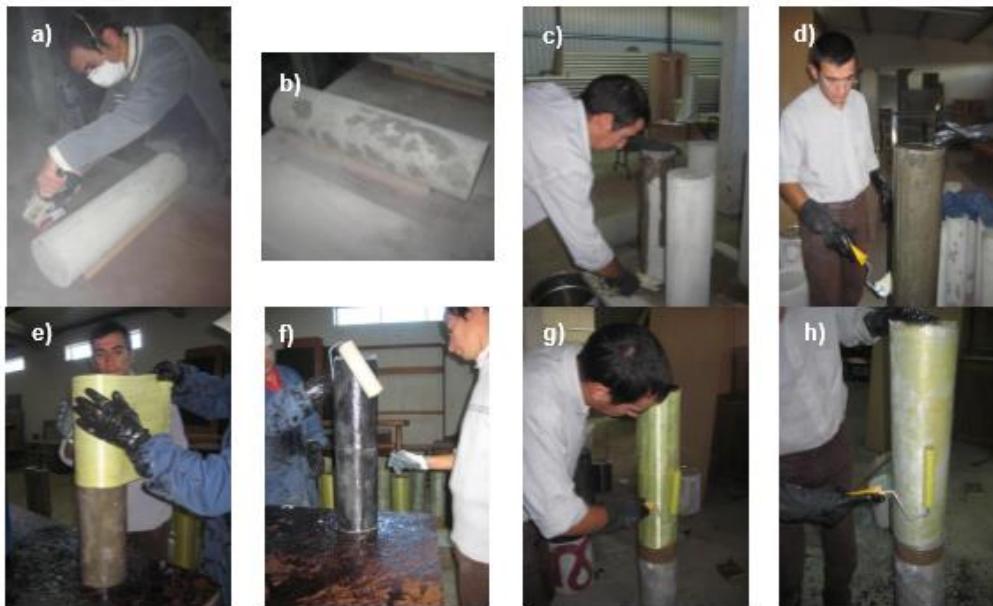
Figura 4.9 Processo de colagem das mantas FRP
