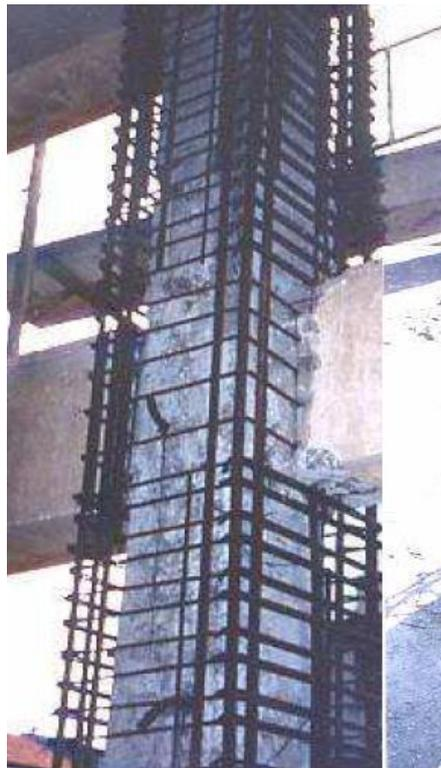
Figura 2.3 – Reforço de um pilar por encamisamento de betão armado (Bousias, Fardis, Spathis, & Biskinis, 2005)
