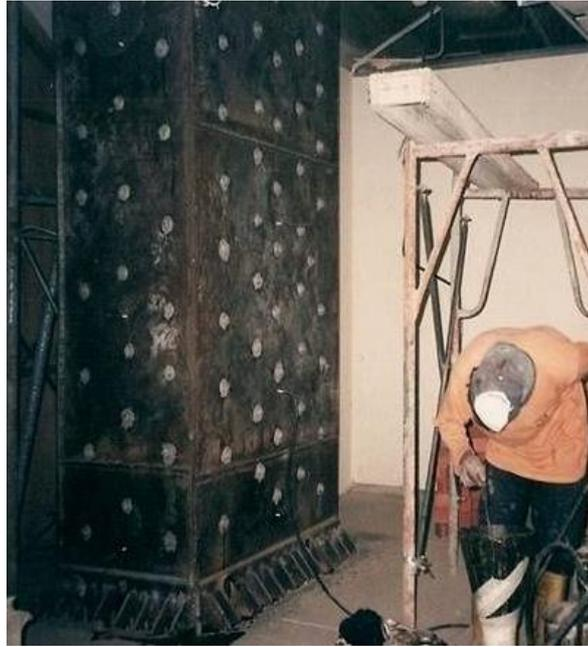
Figura 2.4 – Pilar reforçado por encamisamento metálico (Site da empresa Y.H.H. Engineering Pte Ltd, s.d.)
