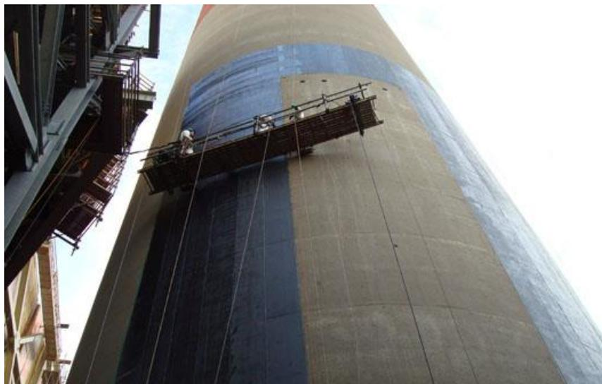
Figura 2.5 – Reforço de um pilar com compósitos de fibras de carbono (Engenharia Civil, 2011)
