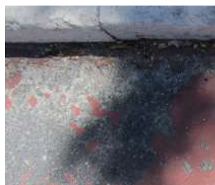
Figura 5.16- Piso já sem revestimento
