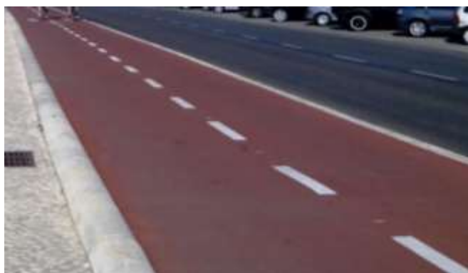
Figura 5.18- Aparência do revestimento da ciclovia
