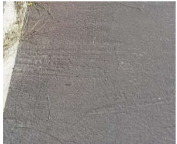
Figura 5.12- Marca do rodo em A2
