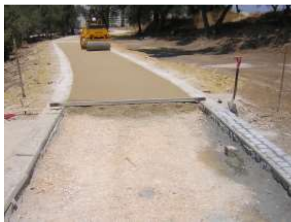
Figura 3.9- Construção de percurso ciclável na Quinta das Conchas com material hidráulico (Foto cedida pela CML, 2015)
