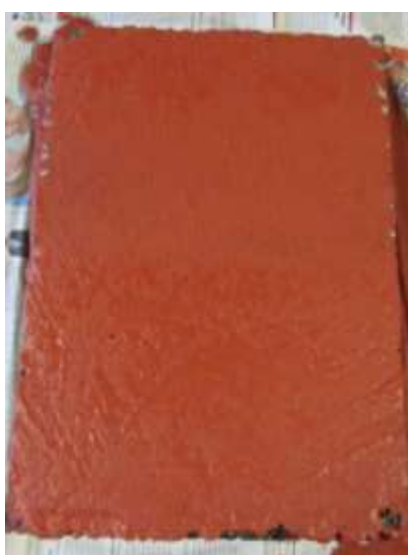
Figura 4.3- Aspeto após colocação do revestimento, ainda húmido
