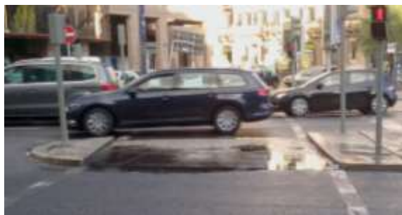
Figura 3.11- Deformações permanentes
