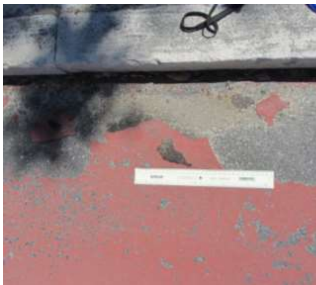
Figura 5.13- Comprimento das peladas
