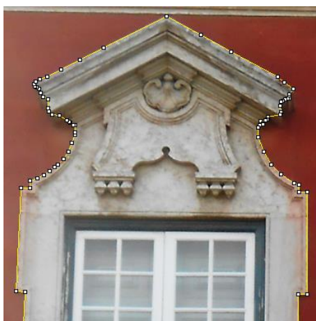
Figura 3.25 - Pormenor do contorno da ombreira em pedra do paramento ID 31 - Palácio Marquês de Fronteira
