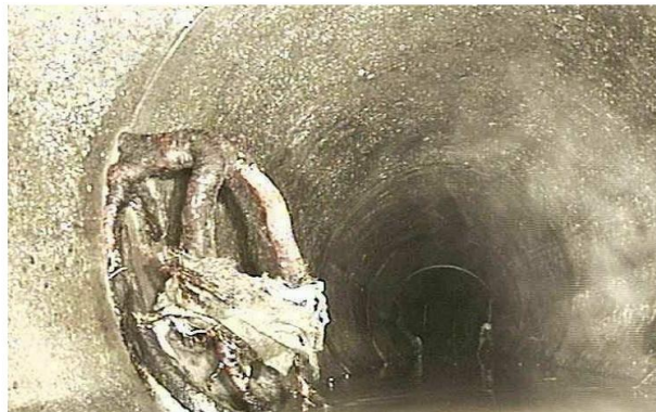
Figura 5.2 - Imagem captada do interior de um coletor recurso a CCTV (EN13508-2:2003)
