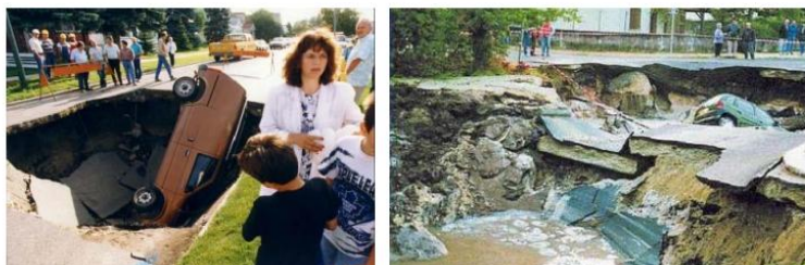
Figura 3.3 - Exemplos de colapsos de coletores noutros países (Breysse et al., 2004)
