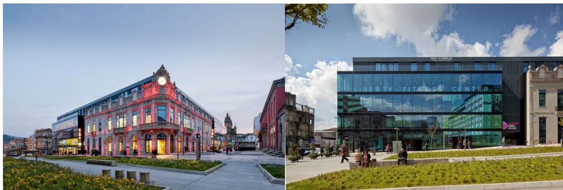
Fig. II.31 Liberdade Street Fashion, antigo edifício dos CTT restaurado, Braga (esquerda)
