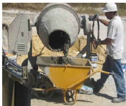
Figura 3.28 - Amassadura do betão
