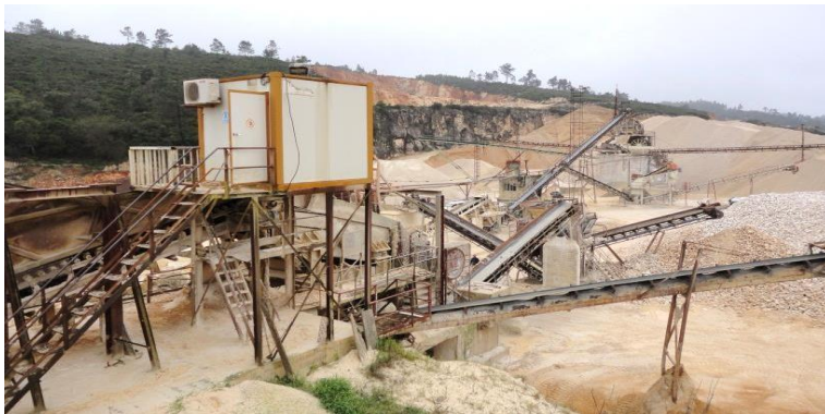
Figura 3.9 - Equipamento de britagem
