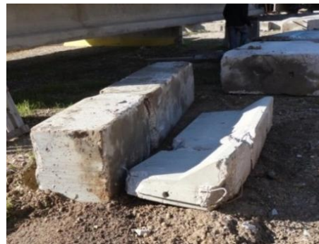
Figura 3.2 - Outros elementos demolidos
