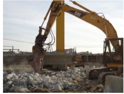
Figura 3.5 - Segunda fase: Giratória com tesoura de maxilas
