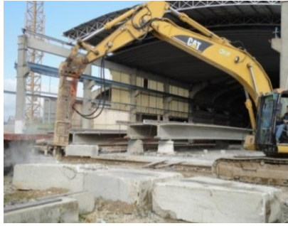
Figura 3.4 - Primeira fase: Giratória com martelo pneumático
