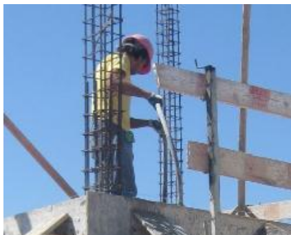
Figura 3.31 - Vibração do betão
