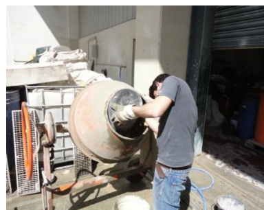
Figura 3.23 - Introdução dos componentes na betoneira
