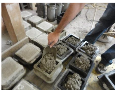
Figura 3.243.24 - Enchimento dos moldes
