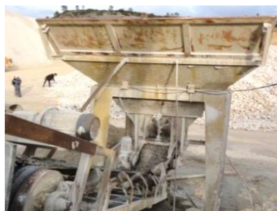
Figura 3.12 - Moinho de martelos (secundário)
