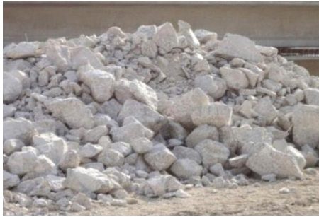
Figura 3.6 - Resíduos resultantes da segunda fase do processo de demolição
