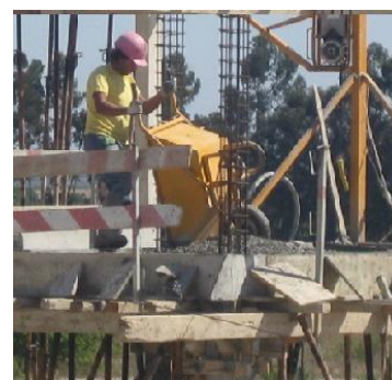
Figura 3.30 - Colocação do betão no pórtico
