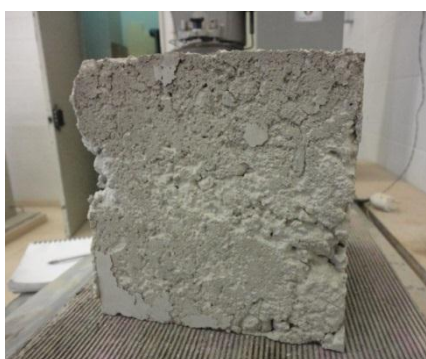
Figura 4.57 - Aspecto geral dos provetes correspondentes ao segundo piso do B25
