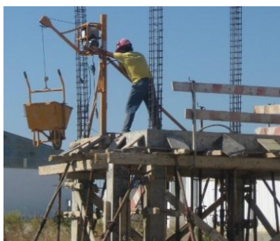
Figura 3.29 - Elevação do betão
