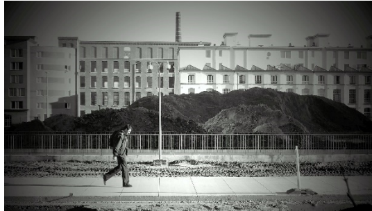
Figura 03.18 (Esquerda) Fábrica de Fiação J. de Hemptinne (s.d.) F: http://onroenderfgoed.be
