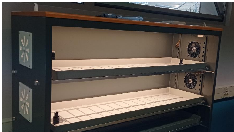
Figura 20. O sistema de ventilação, que consiste de uma ventoinha e uma grelha de ventilação do lado oposto, no nível 2 e nível 3.
