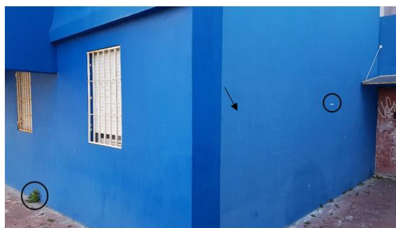
Figura 5 - Aspeto dos paramentos aquando a inspeção visual
