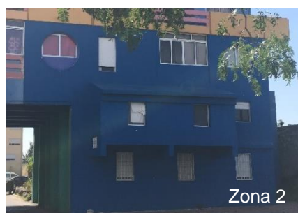
a) Reboco térmico aplicado em 2015
