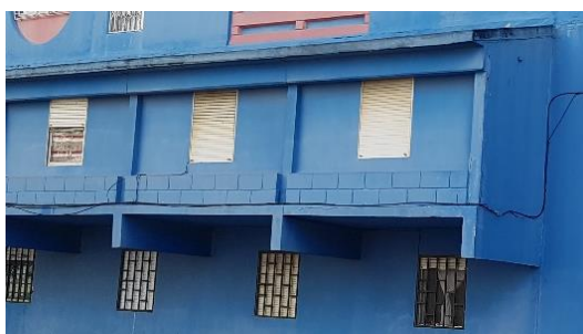
a) Zona não intervencionada
