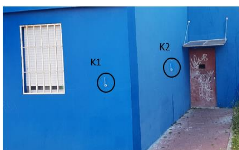
Figura 7 - Localização dos ensaios dos tubos de Karsten
