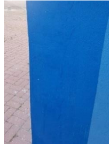
Figura 4 - Zona de remate da rede do sistema de isolamento térmico aplicado em 2015
