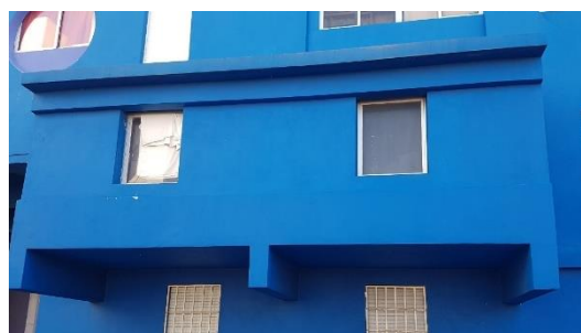
b) Zona intervencionada
