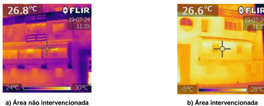
Figura 8 - Análise termográfica da região intervencionada e não intervencionada
