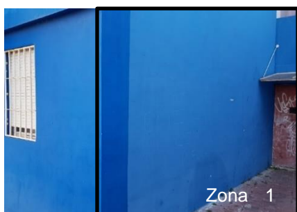
a) Reboco térmico aplicado em 2014 (moldura preta)
