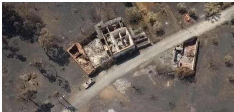
Figura 13 – Fotografia aérea, extraída de um drone, ilustra os danos do incêndio. Adaptado de RTP Notícias
