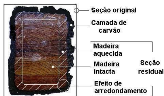
Figura 10 – Viga de madeira carbonizada. Extraído de Anastácio, 2010.
