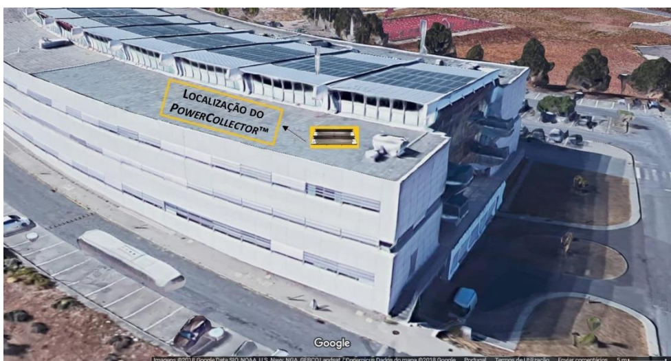
Figura 23 - Vista aérea do edifício do Taguspark onde foi instalado o PowerCollector TM
