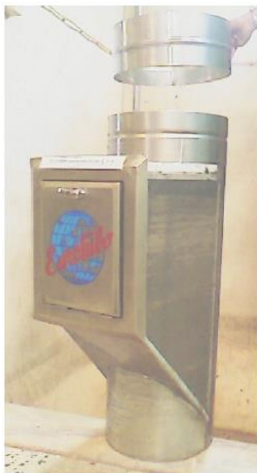
Figura 17 - Estrutura, 1, exemplar de uma conduta de transporte de lixo.
