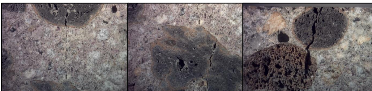
Figura 45: Fendas naturais induzidas nos BEAL com agregado Leca. Fendas tortuosas que na zona dos agregados tende a apresentar maior abertura
