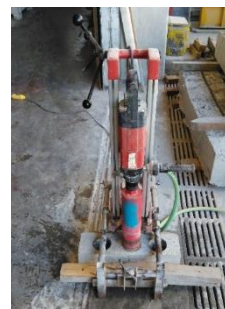
Figura 13: Processo de carotagem de uma viga
