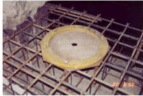
2 – Colocação da chapa de base do aparelho
