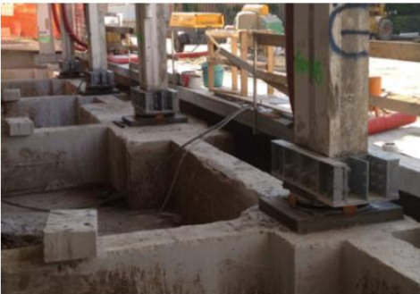
Figura 32 - Procedimento de instalação de isoladores em fundações de betão armado (adaptado de Luca Trombetta et al, 2014)
