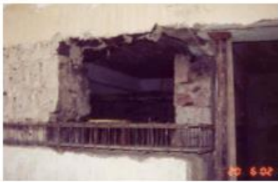
3– Armadura das vigas
