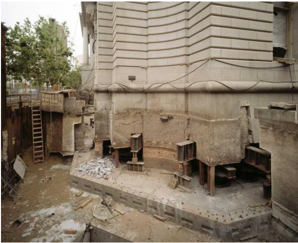
Figura 49 - Procedimento de instalação de aparelhos numa estrutura metálica (adaptado de Canfield, s.d.)
