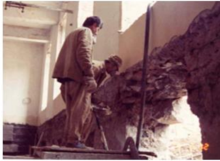
1 – Abertura do buraco na parede de alvenaria
