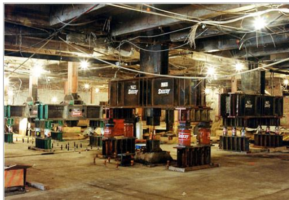
Figura 50 -Edifício “Oakland City Hall” (A), Técnica “column cut” utilizada na intervenção de reforço do edifício (B) (adaptado de (Forell / Elsesser Engineers, s.d.) e (Sheedy Drayage Co., s.d.)
