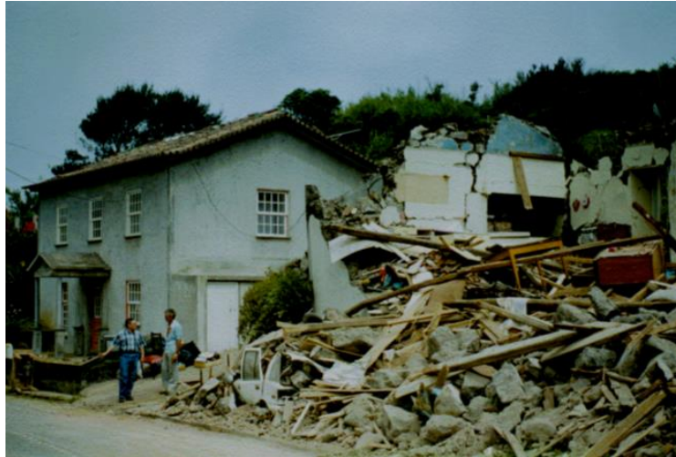
Figura 1 – Diferença entre danos causados após um sismo entre um edifício reforçado sismicamente e outro não (SPES, 2012)
