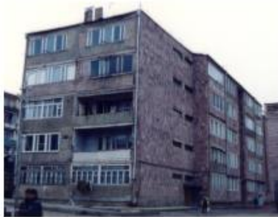
Figura 42 -Edifício de apartamentos reforçados com isolamento de base (Melkumyan, 2014)
