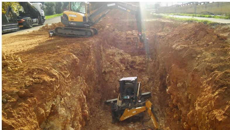
Figura 29 – Escavação realizada junto ao PM136
