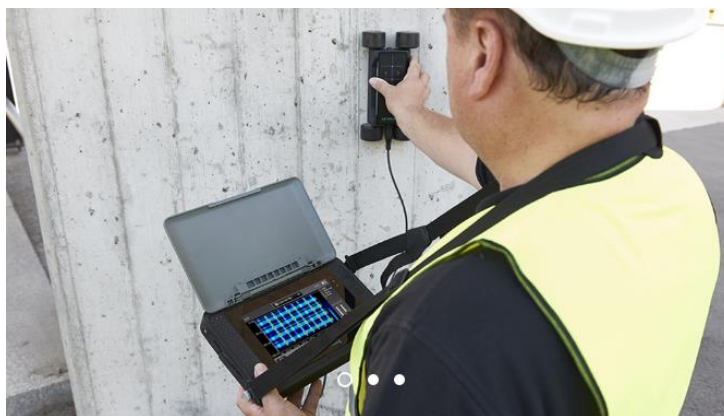
Figura 56 – Utilização do equipamento profoscope da proseq (retirado do https://www.proceq.com/compare/rebar-detection-and-cover-measurement/ , acedido a 15 Outubro)
