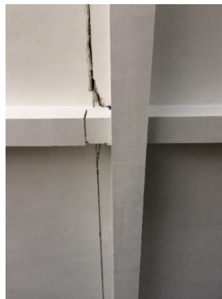
Figura 21 – Junta de dilatação
