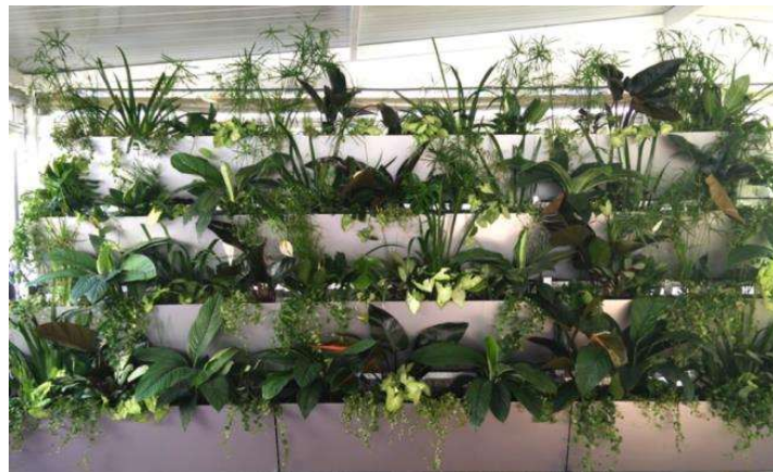
Figura 3.4 - Parede verde responsável pelo tratamento das águas dos lavatórios e duches provenientes dos quartos de hóspedes.
