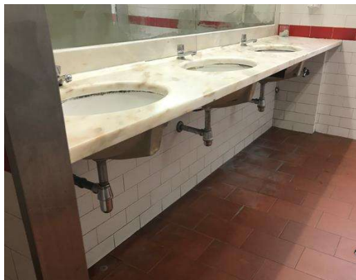
Figura 5.3 – Local onde se pretende instalar os reservatórios de regularização.
