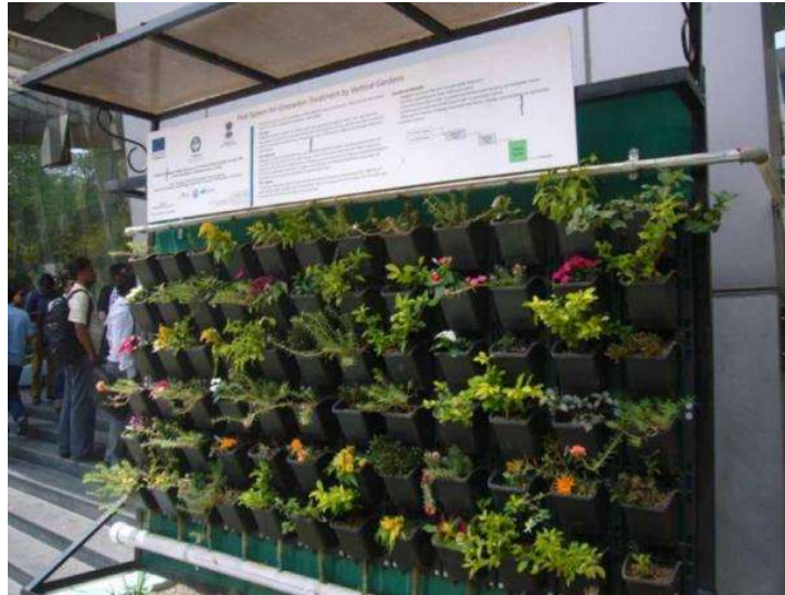
Figura 3.5 - Parede verde responsável pelo tratamento das águas provenientes dos lavatórios dos pisos 1 e 2 de um escritório em Pune.
