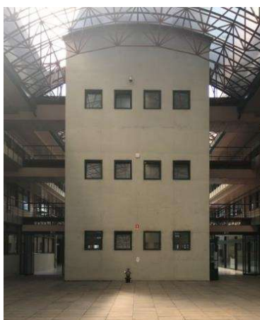
Figura 5.4 – Torre central do pavilhão de civil.
