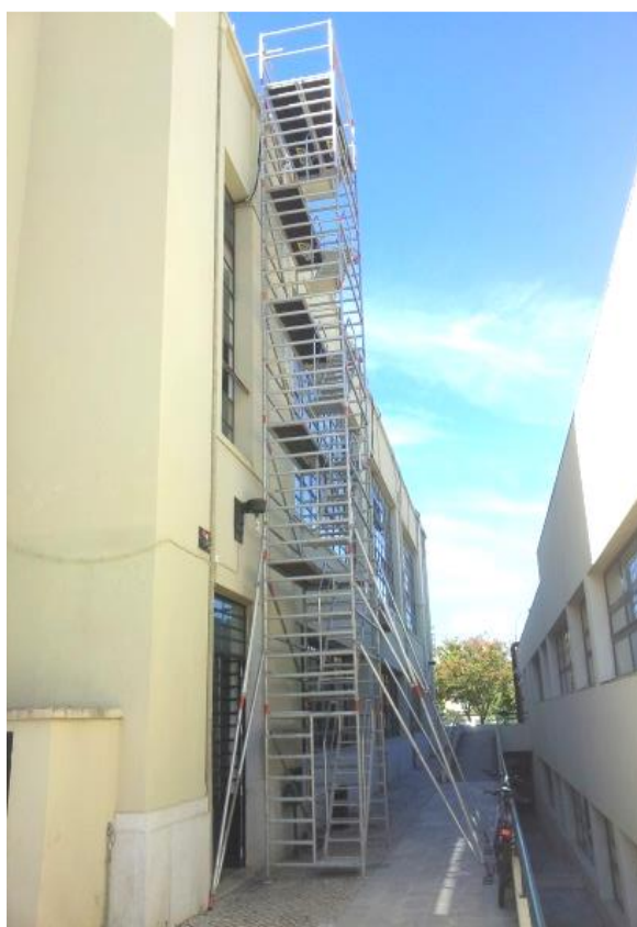
Figura 3.2 - Andaime de acesso para a substituição das tubagens
