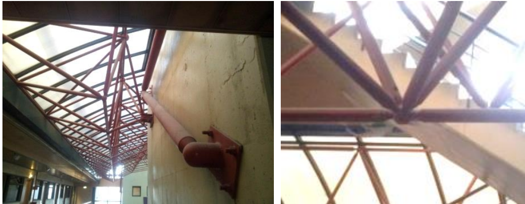
Figura 3.5 - Treliza sob a clarabóia central - esquerda; Nível de sujidade na treliza - direita
