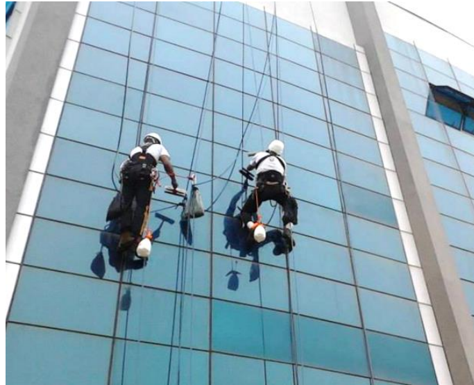
Figura 2.5 - Alpinistas durante a actividade de manutenção [W3]
