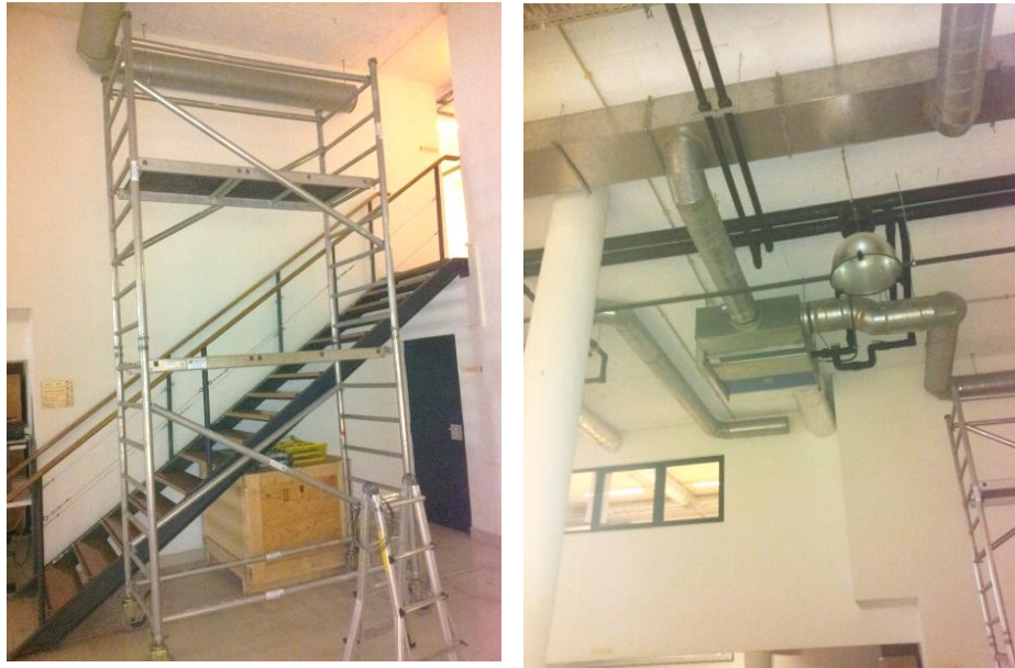
Figura 3.6 - Andaime de acesso interior - esquerda; equipamento e conduta AVAC - direita
