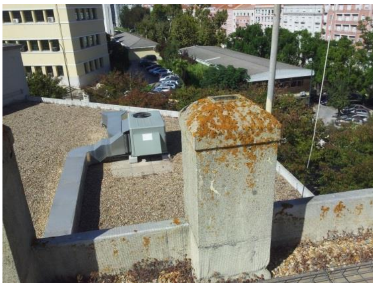
Figura 3.1 - Colonização biológica no elemento construtivo
