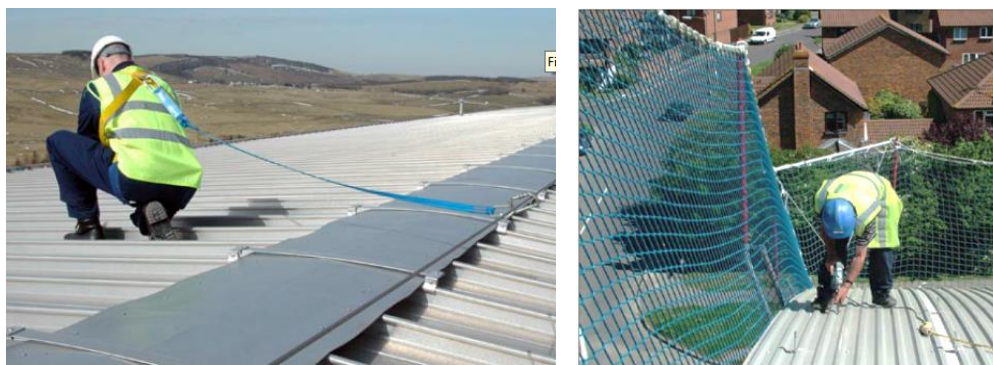
Figura 2.12 - Arnês de segurança (Cameron et al, 2005) - esquerda; Andaimos para a chaminé e rede no perímetro da cobertura (HSE, 2012b) - direita
