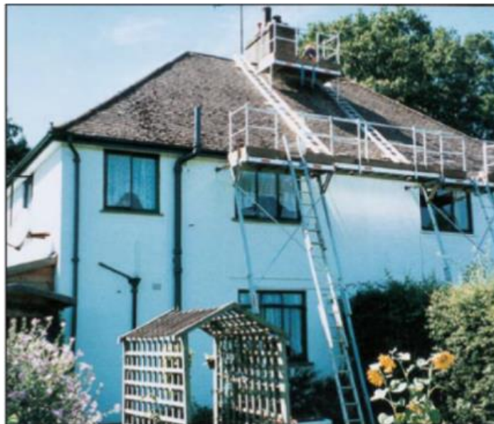
Figura 2.11 - Escadas aplicadas directamente sobre a cobertura inclinada
