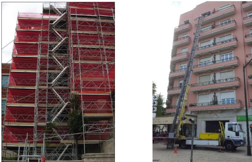
Figura 2.7 - Torre de escadas (HSE, 2012b) - esquerda; equipamento de acesso móvel - direita
