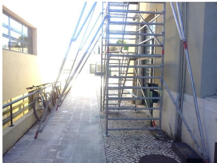
Figura 3.3 - Sistema de contraventamento e estabilizadores do andaime
