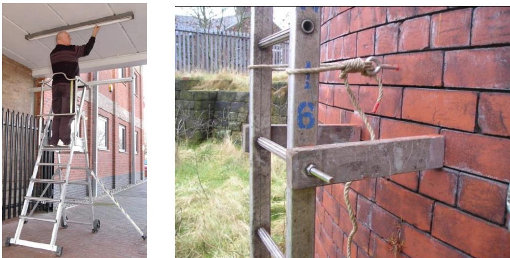
Figura 2.8 - Escada com uma plataforma de suporte (HSE, 2006) - esquerda; Representação de uma unidade de ancoragem, (ATLAS, 2014) - direita
