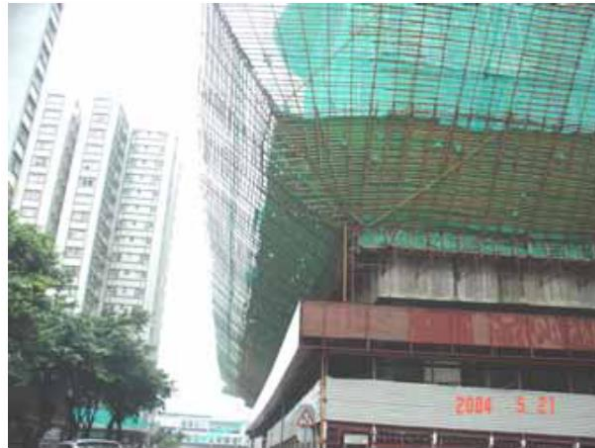
Figura 2.14 - Protecção da zona de circulação (REDAHK & HKCA, 2005)
