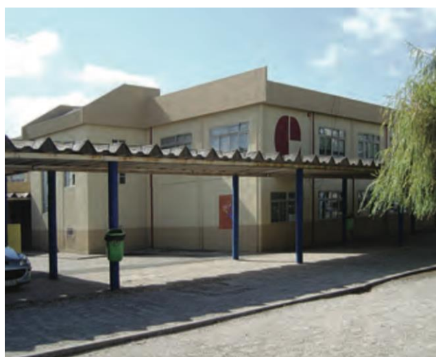
Figura 3-8 - Galeria coberta, Escola Secundária D. João V, Damaia. [23]
