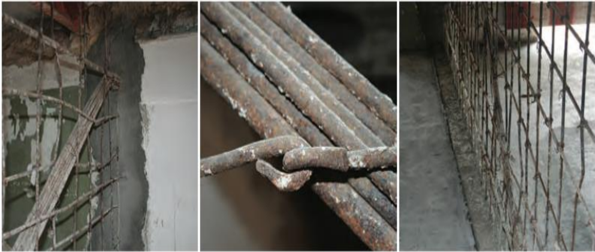
Figura 3-13 - Paredes divisórias de betão armado [23]
