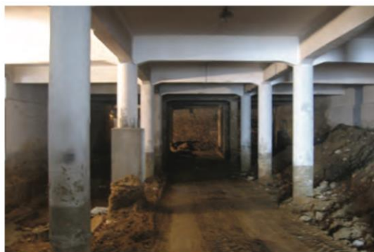
Figura 3-19 - Estrutura de apoio dos ginásios existentes [23]
