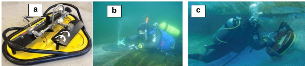
Fig. 53 – Limpeza de fouling in situ
