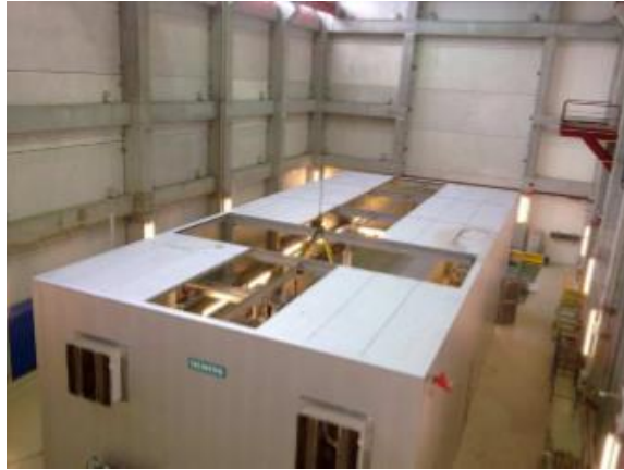
Figura 3.3: Instalação do grupo turbogerador TG4, no CIFF [45]
