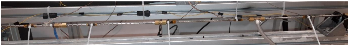
Figura 13 - Zona de testes com as ligações, tubos e termopares.
