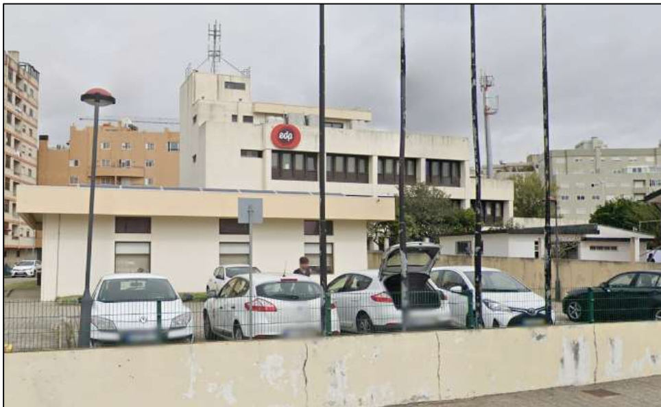
Figura 4.1 - Foto do Edifício073
