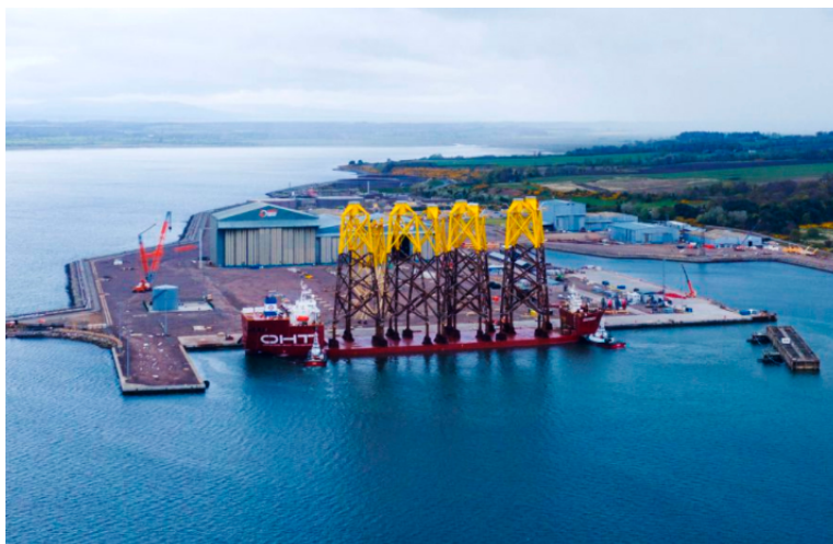
Figura 1.1: Projecto Windfarm com 8 jackets de um total de 103 no Porto de Nigg, na Escócia para aproveitamento de energia eólica [1].
