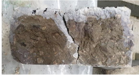
Figura 4.11 - Provete sujeito a penetração de cloretos com fenda natural
