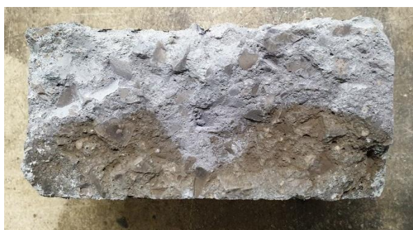
Figura 4.9 - Provete sujeito a penetração de cloretos com fenda artificial
