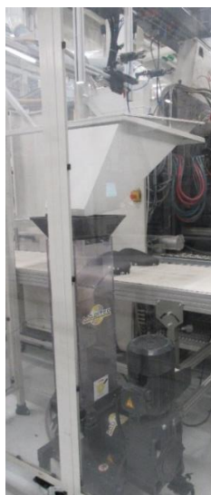
Figura 11: Sistema de corte, trituração e recirculação de jitos
