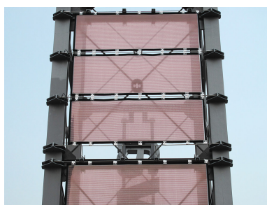
(a) Primeira instalação ligada à rede elétrica utilizando OPVs em Mainova, Frankfurt (2012).
