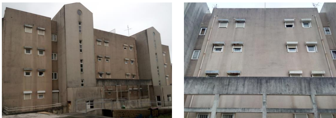
Figura 3.34 - Aspeto geral da fachada excluída da amostra, na Rua Aristides Sousa Mendes, em Vila do Conde
