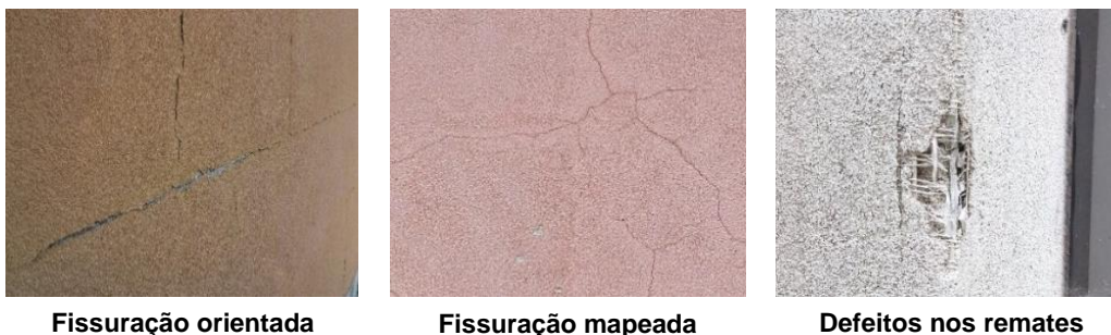
Figura 2.5 - Exemplos ilustrativos de anomalias de perda de continuidade/integridade
