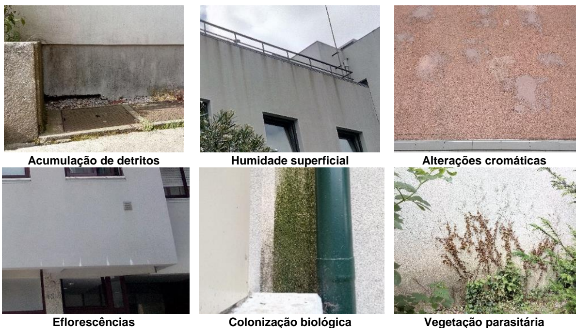
Figura 2.3 - Exemplos ilustrativos de anomalias do tipo manchas/alterações cromáticas
