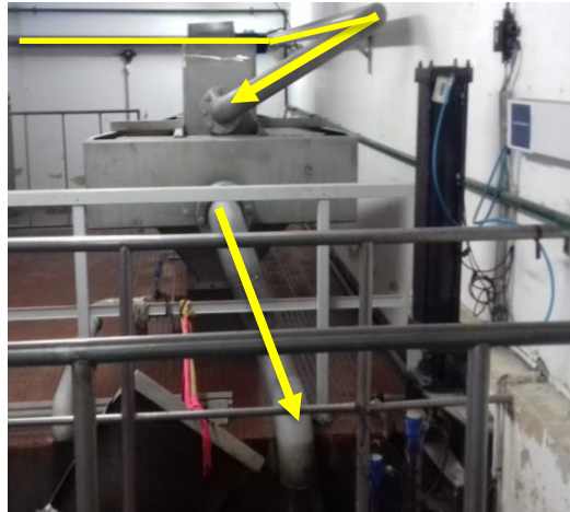
Figura 38 - Etapa de classificador de Areias e recirculação nos tamisadores
