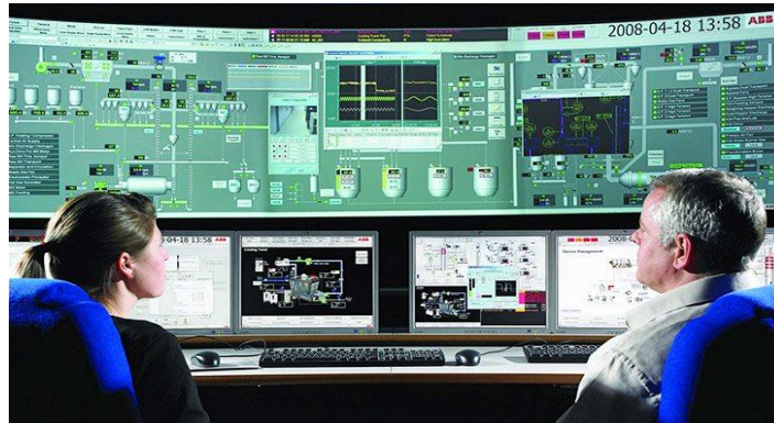
Figura 26 - Sala de controlo genérica do SCADA, [30]
