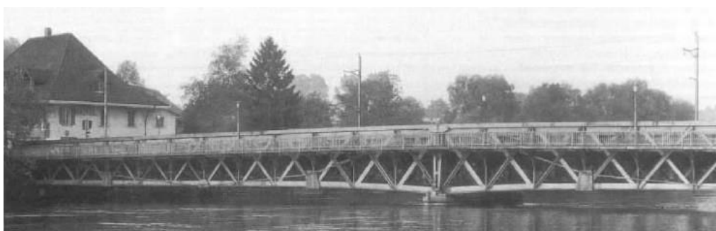
Figura 2.13 - Ponte ferroviária com pré-esforço exterior (Preto, 2014).
