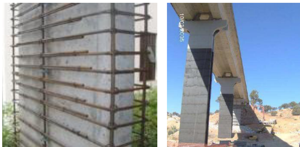
Figura 2.7 - (a) Encamisamento metálico de um pilar. (b) Encamisamento com betão de um pilar (Costa, António; Appleton, Júlio, 2011).
