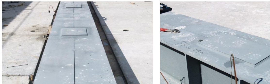
Figura 3.36 – Elementos metálicos soldados aos perfis HEB550.
