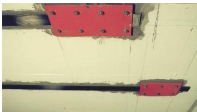
Figura 2.14 - Pré-esforço exterior com laminados (Costa, 2014).
