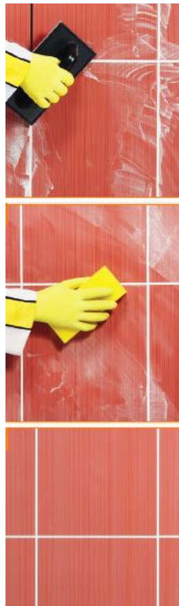
Figura 17. Processo e betumação de juntas [41]
