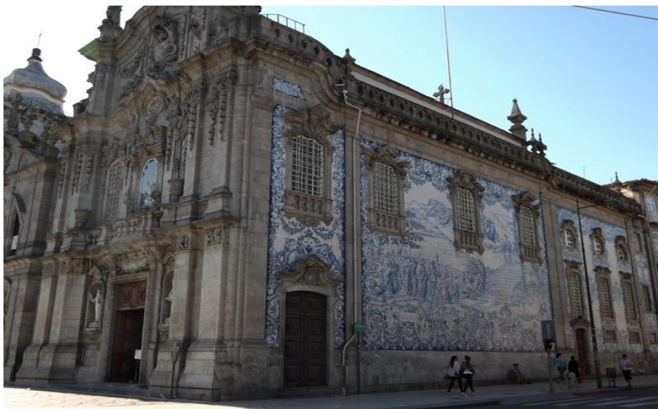
Figura 7. Igreja do Carmo, Porto – Fachada de azulejo [16]
