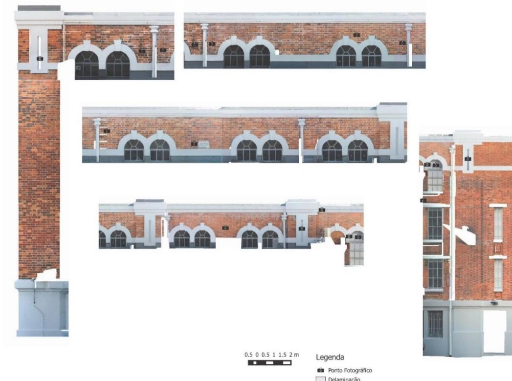
Figura 25 - Distribuição da delaminação na fachada oeste do Edifício de Escritórios e SubEstação
