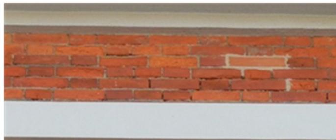
Figura 24 – Exemplo de desintegração das juntas de argamassa detetadas na Central Tejo
