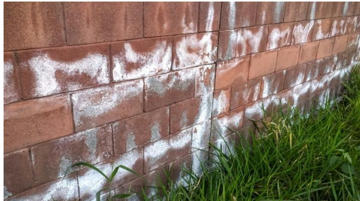
*Figura 10 - Exemplo de eflorescências em alvenaria*
