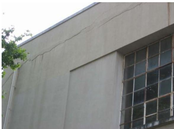
*Figura 8 - Exemplo de fissuração resultado do desligamento de elementos*
