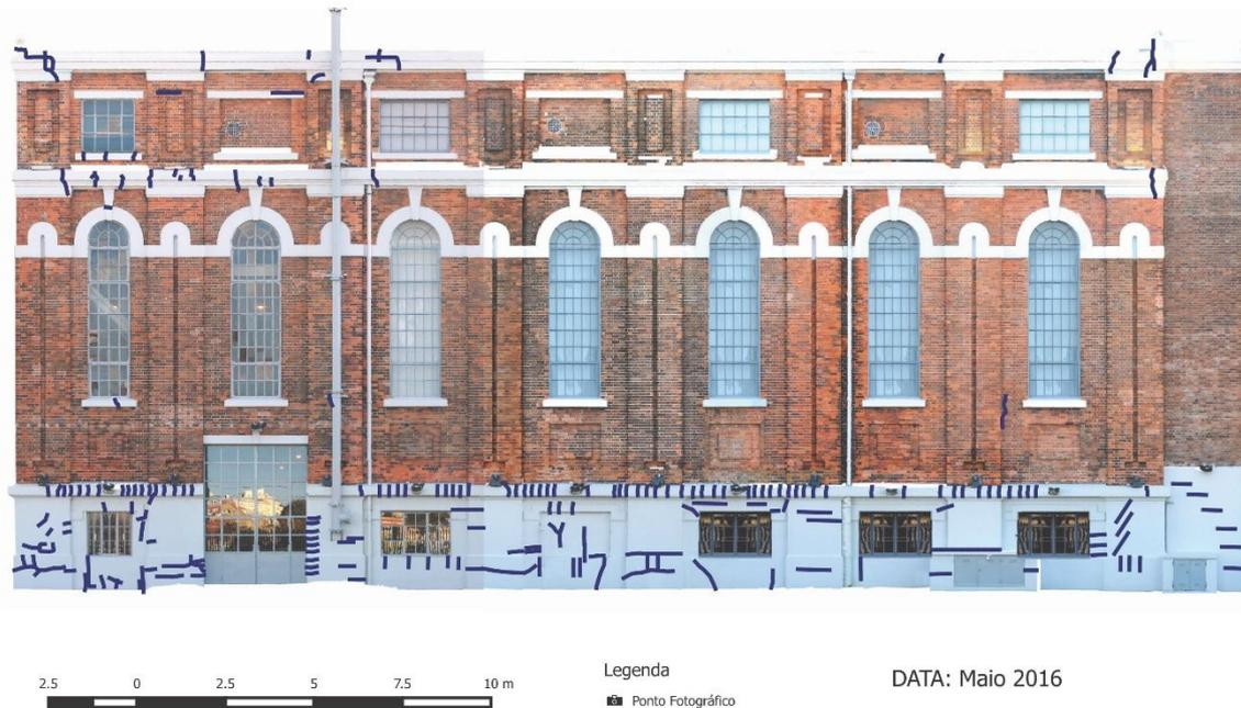
Figura 18 - Distribuição das fissuras detetadas na fachada norte do Edifício de Baixa Pressão
