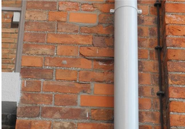
*Figura 26 - Exemplo de delaminação detetada na Central Tejo*
