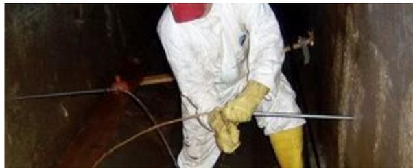
*Figura 17 – Exemplo de injeção em alvenaria*
