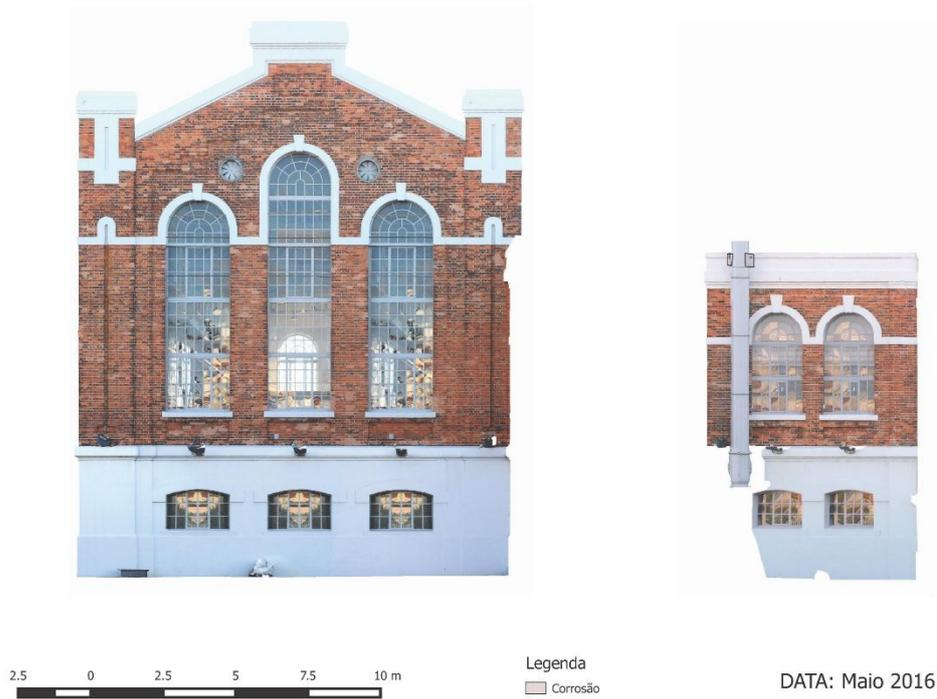
Figura 29 - Distribuição de corrosão no Edifício da Sala das Máquinas
