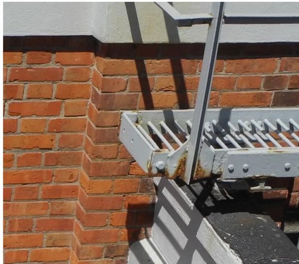
Figura 30 - Exemplo de corrosão detetado na Central Tejo
