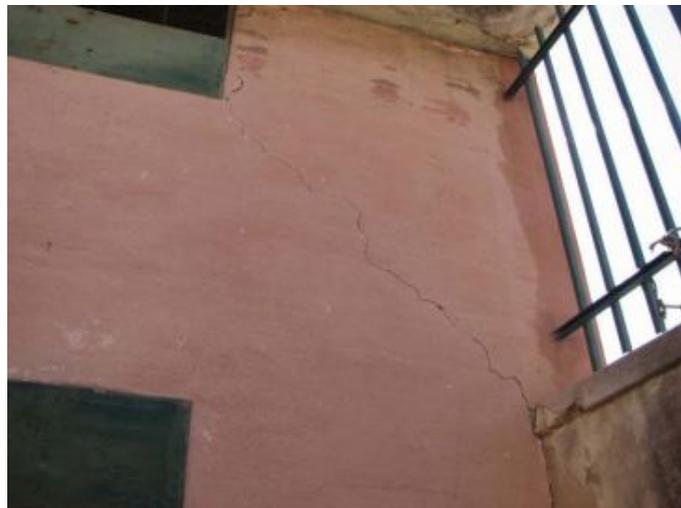
*Figura 7 - Fendilhação resultado de assentamento diferencial*
