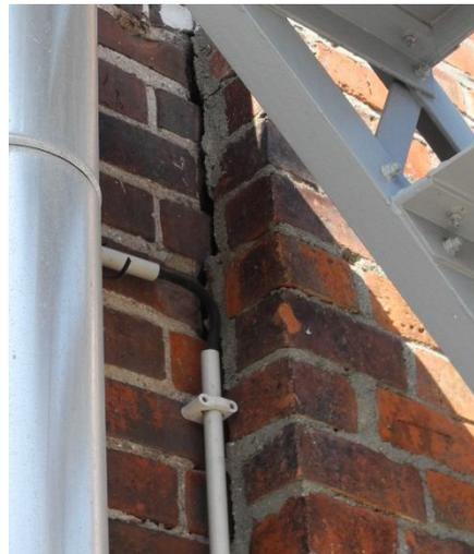
Figura 19 - Exemplo de fissura com abertura superior a 2 mm detetadas na Central Tejo
