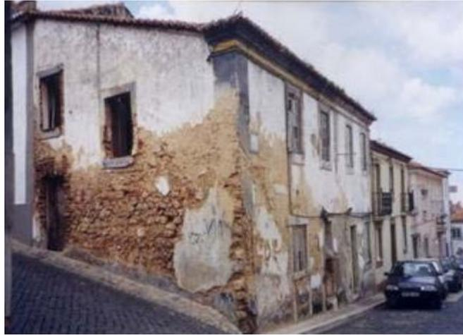
*Figura 9 - Exemplo de desagregação em alvenaria*
