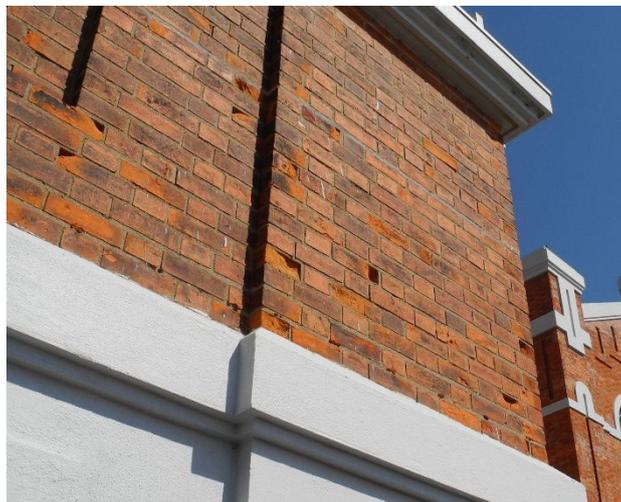
Figura 28 - Exemplo de erosão detetado na Central Tejo
