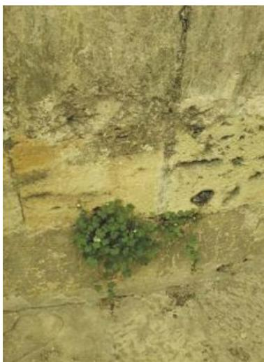
*Figura 11 - Exemplo de vegetação parasitária em alvenaria*
