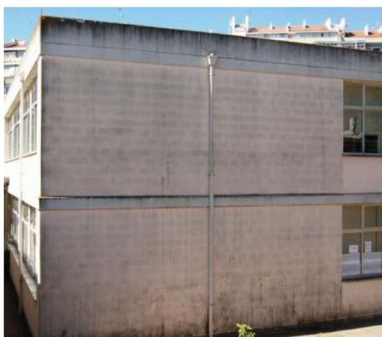
*Figura 12 - Exemplo de termoforese em alvenaria*
