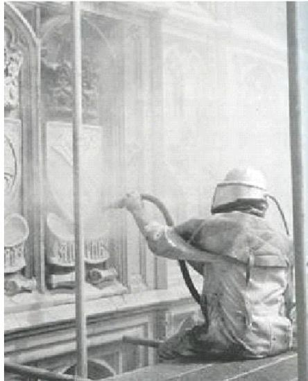
Figura 20 - Técnica de micro jatos de precisão com partículas abrasivas
