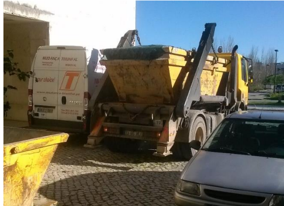
Figura 26 Transporte do entulho
