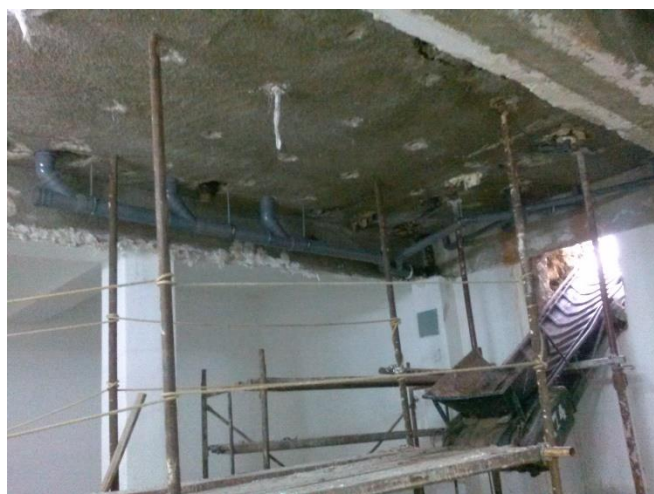
Figura 22 Plataforma de retirada do entulho
