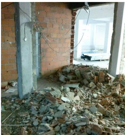
Figura 25 Demolições no empreendimento
