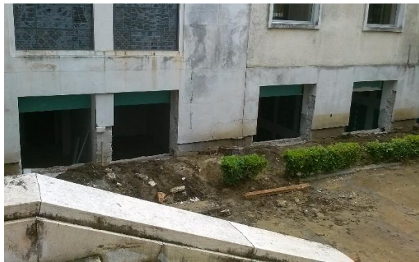
Figura 27 Janelas do Piso -1
