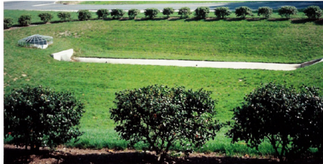
Figura 2.12 - Exemplo de uma bacia de detenção a seco (USEPA, 1995).
