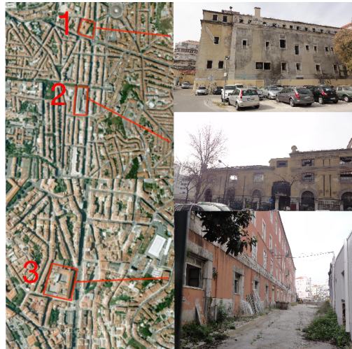
Figura 4.7 – Identificação e localização dos locais escolhidos para implantação de bacias de retenção
