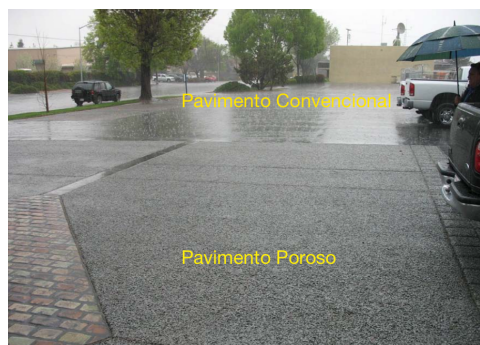
Figura 2.15 – Comparação entre os dois tipos de pavimentos adaptado de (Huffman, 2008).
