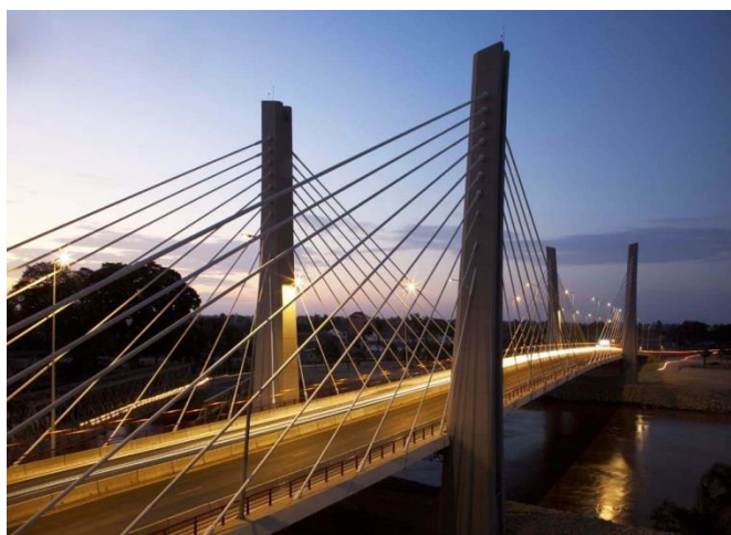
Figura 3.1 – Vista em perspectiva da Ponte 4 de Abril.
