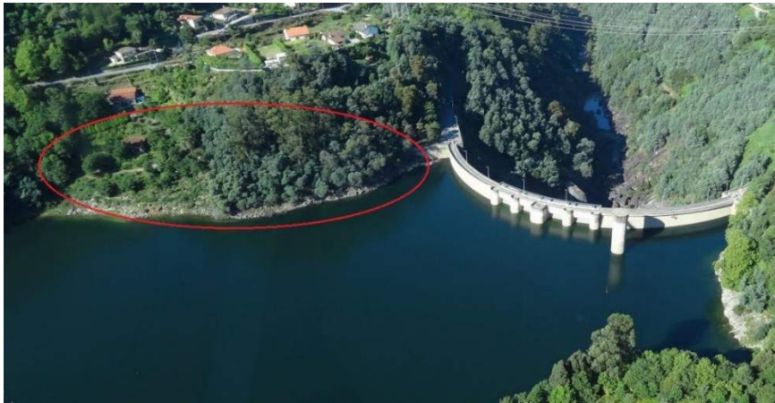
Figura 3.8: Fotografia aérea do local de implantação da solução adotada (adaptada de http://terrasbouro.blogspot.pt/2012/10/barragem-da-canicada.html - 13:06 dia 05/12/2014).
