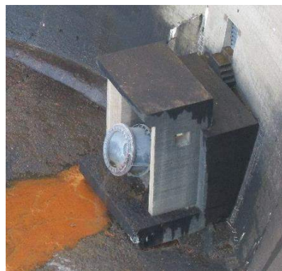
Figura 3.4: Pormenor da descarga de fundo da barragem da Caniçada.
