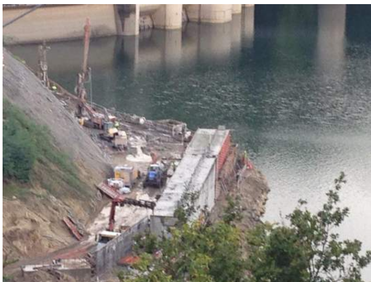
Figura 3.10: Vista da zona onde decorreram os trabalhos da construção da ensecadeira.
