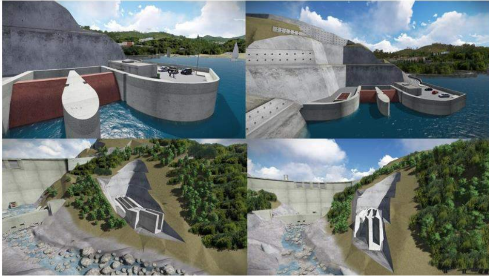
Figura 3.7: Modelo tridimensional do Descarregador de Cheias Complementar da barragem da Caniçada: em cima tomada de água; em baixo restituição (adaptada de EDP (2015)).
