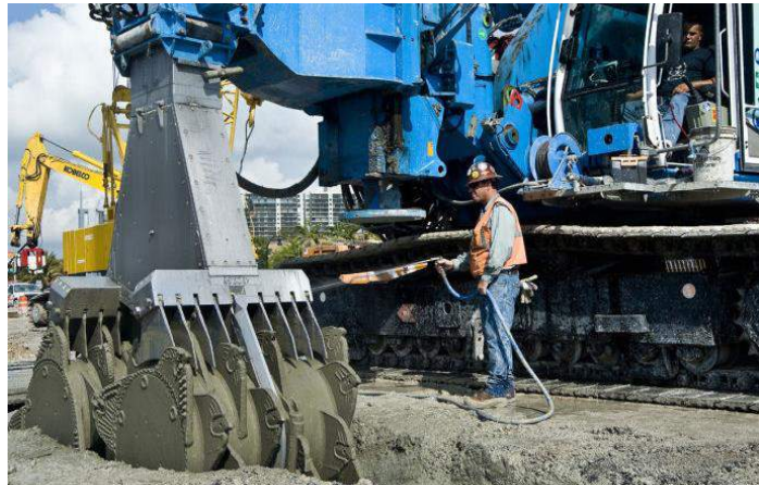
Figura 5.37: Hidrofresa e ferramenta de corte utilizados na tecnologia de CSM (adaptada de Malcolm Drilling Company, Inc.).
